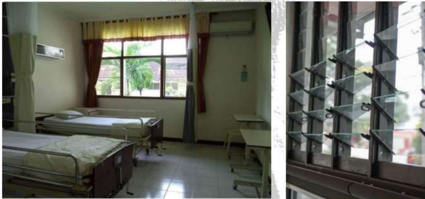
Gambar 27. Louvre pada ruang Kana RS Mardi Rahayu Kudus (Sumber: dokumen penulis)
